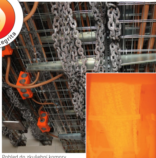
Pohled do zkušební komory
