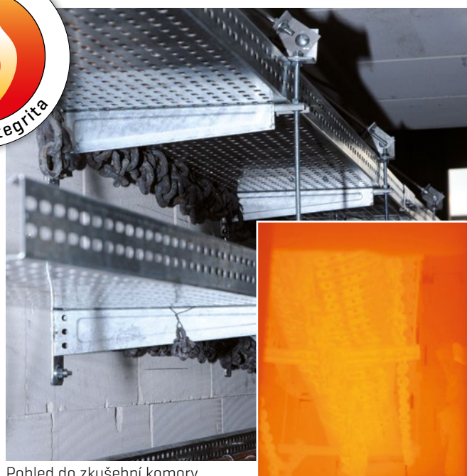
Pohled do zkušební komory
