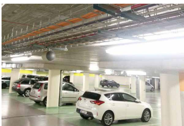
▲ Podziemne pomieszczenia parkingowe.
