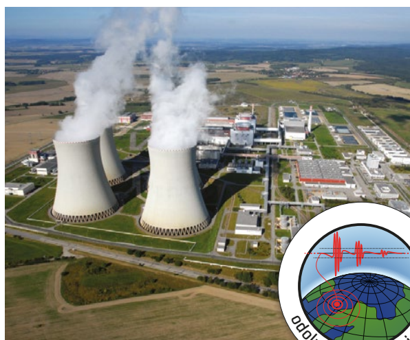
> Systém MERKUR byl schválen pro seismicky odolné kabelové trasy v jaderných elektrárnách Temelín a Dukovany.
