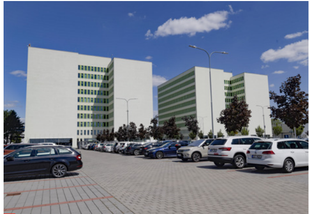
⬆ Der Sitz des Unternehmens und das Verwaltungszentrum befinden sich im Gebäude „O“ im Komplex AREAL SLATINA.
