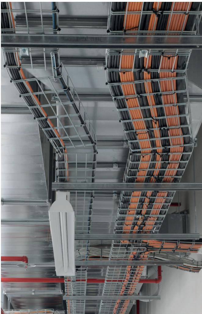
povrchová úprava nejvhodnější. Při této metodě zinkování dochází k nanesení vrstvy zinku na povrch ocelových výrobků. Zinek chrání povrch žlabů nejen mechanicky, ale i chemicky, když při porušení lokální vrstvy zinku dochází ke korozi jen v zinkové vrstvě, tím pádem ocel zůstává nepoškozena do doby, než se rozpustí zinková vrstva.
