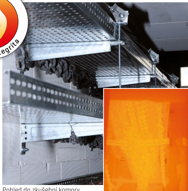
Pohled do zkušební komory
